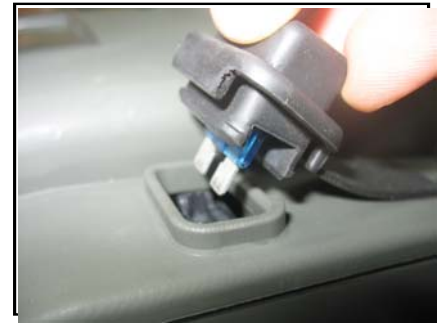
Figure 1.27 - Introduction du fusible des batteries
